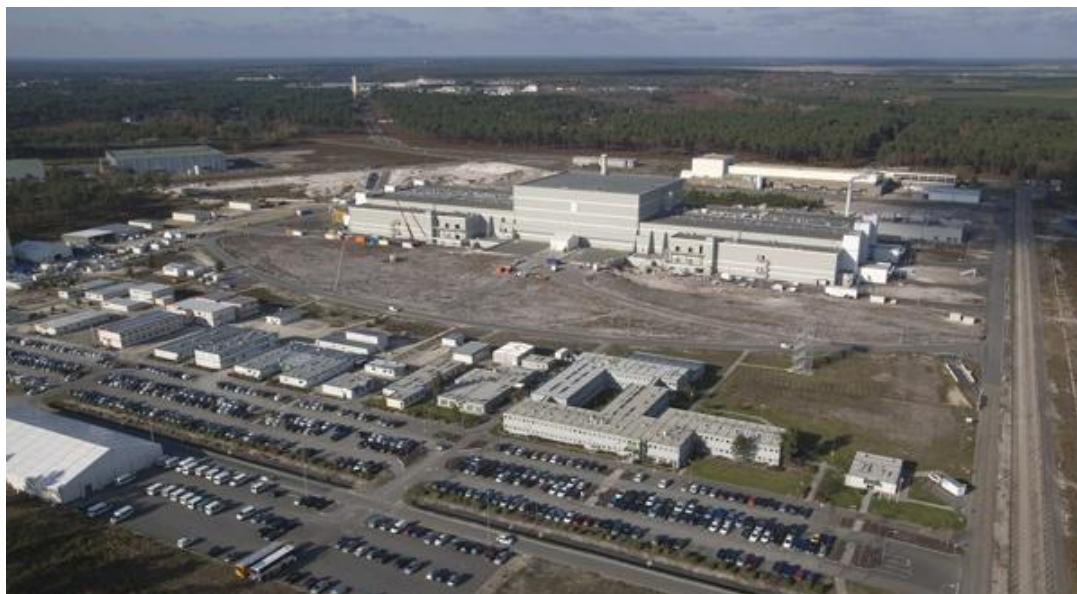
建设中的 LMJ 装置
